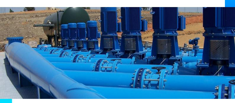
Los carretes de desmontaje se fabrican según la ubicación final de dicho elemento, fabricándose con virolas en acero al carbono o en acero inoxidable y bridas en acero al carbono, con tornillería bicromatada, para otros ambientes mas corrosivos se pueden fabricar con bridas también en acero inoxidable.
